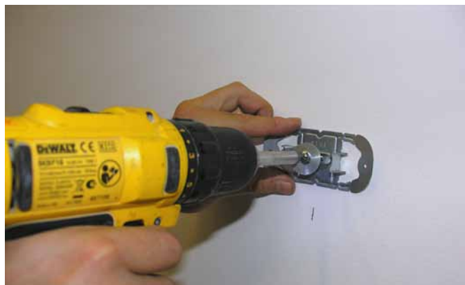
Obr. 13: Upevnění klipů pro přímou montáž
