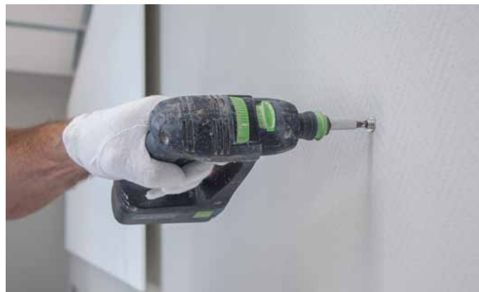
Obr. 7: Pevné přešroubování magnetických patic.
