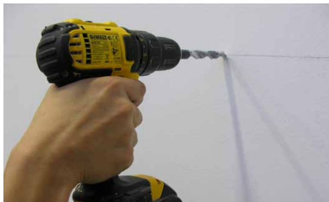
Obr. 12: Vyrvtání otvorů pro upevňovací prostředky
