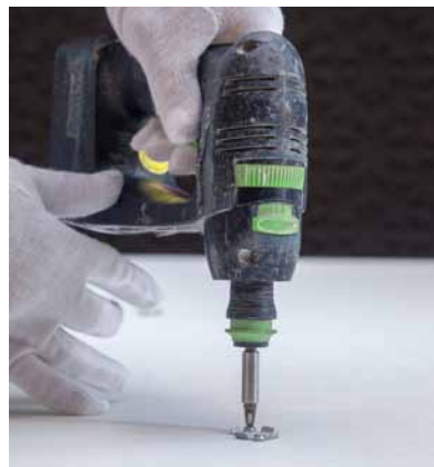
Obr. 6: Upevnění plechových držáků
