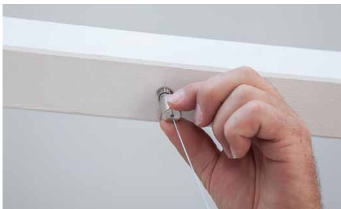
Obr. 21: Pevně přišroubujte vrchní díly závěsu
