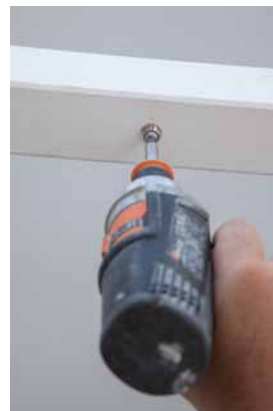
Obr. 20: Upevnění patice závěsu
