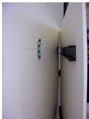
Obr. 14: Osazení stěnového absorbéru Cleaneo Single Smart
