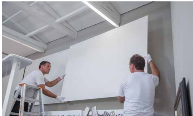
Obr. 9: Umístění stěnového absorbéru Cleaneo Single Smart
