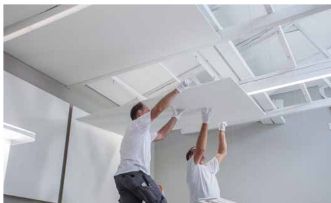
Obr. 23: Vyrovnání stropního dílce Cleaneo Single Smart
