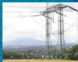
Sloupy VN , nátěr Knauf TS 730
