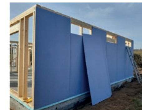
> Příklad opláštění deskami Knauf Diamant z praxe
