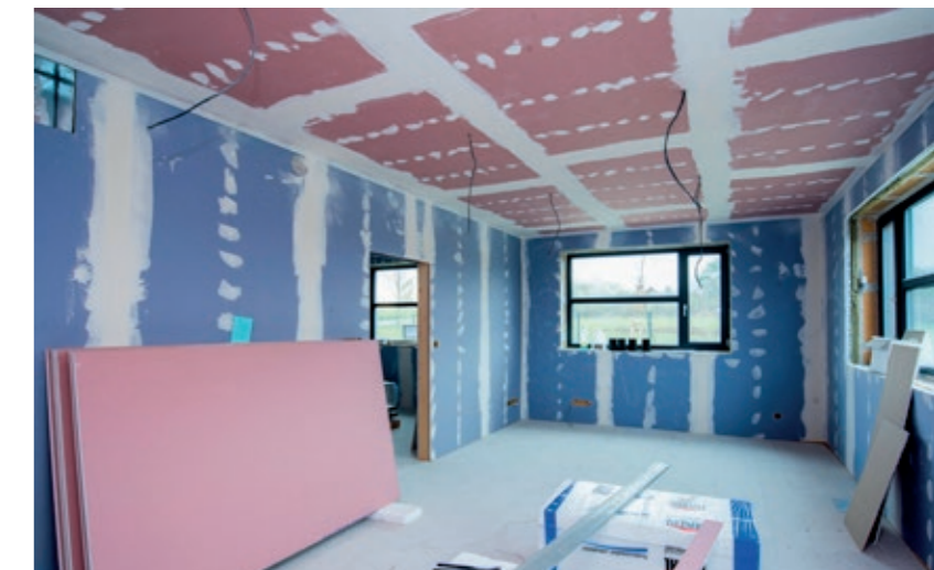
> Dvojitě opláštění deskami Knauf Diamant zajistí v dřevostavbách akustickou pohodu. Knauf RED Piano v případě nenosného stropu řeší protipožární, ale i akustickou funkci
