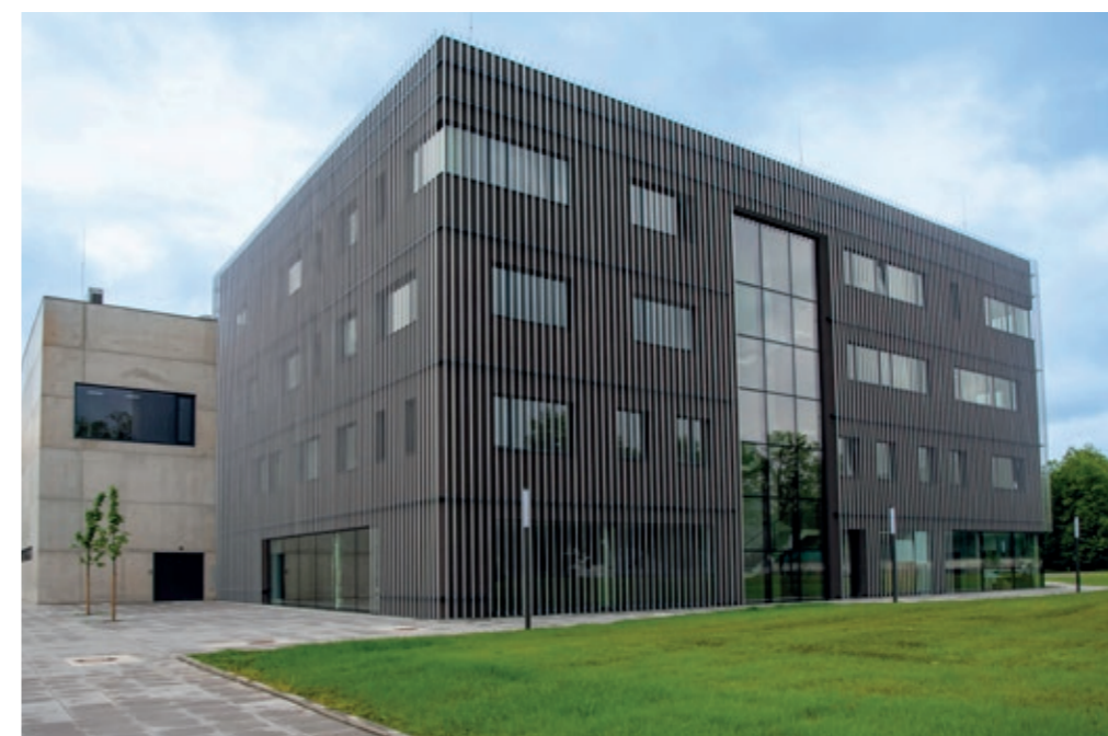
> Minimalistický design hudební fakulty s dvěma na sebe navazujícími budovami
