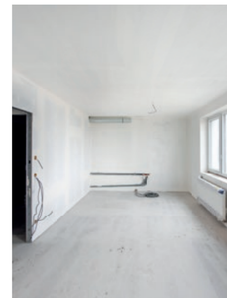
> Příčky v bytech jsou provedeny za pomoci akustického sádrokartonu Knauf Diamant
