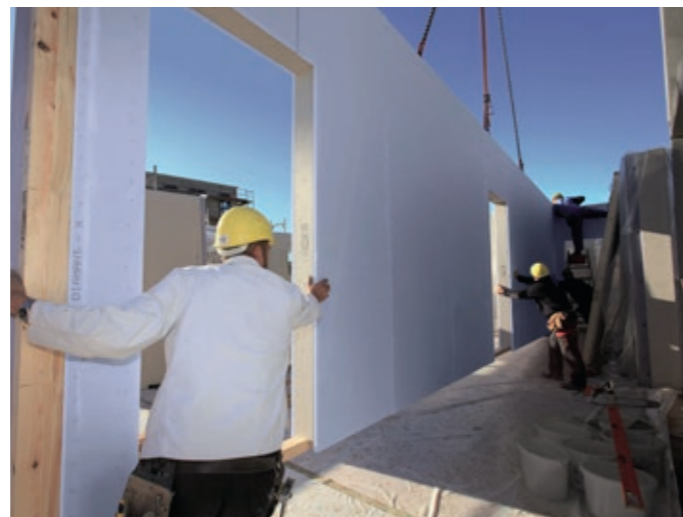
> KNAUF Diamant X je první sádkartonovou deskou s Evropským technickým schválením (ETA) pro zajištění rámové tuhosti dřevěných i kovových konstrukcí
