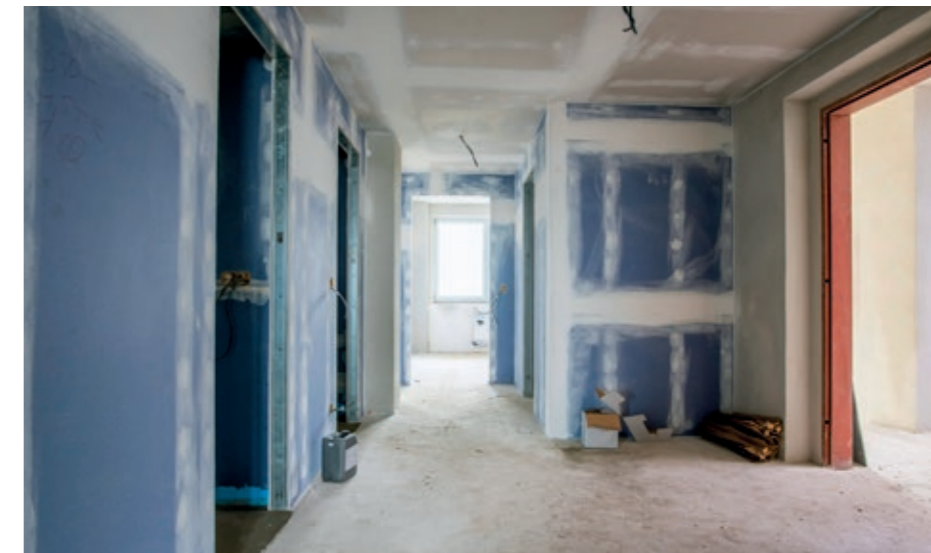
> Příčky v bytech jsou provedeny za pomoci akustického sádrokartonu Knauf Diamant
