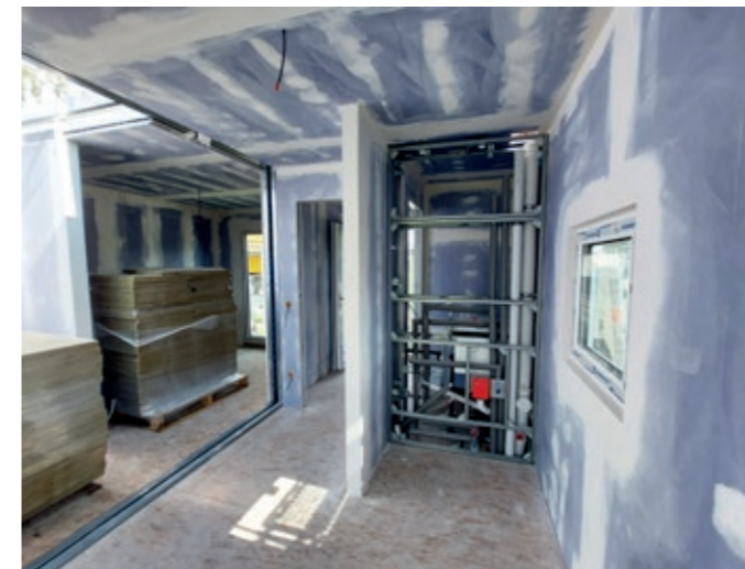
> Knauf Diamant X je v ocelové konstrukci multifunkční – postará se o její tuhost, příjemnou akustiku, požární odolnosti i dokonalý vzhled
