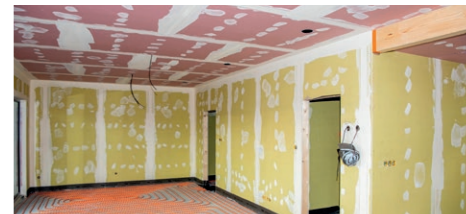
> Sádkartonová deska KNAUF TOPAS (žlutý karton) má pevné jádro, je protipožární a impregnovaná. To je ideální kombinace vlastností pro její použití v dřevostavbách, kde exceluje i jako výztužná deska v obvodovém pláště
