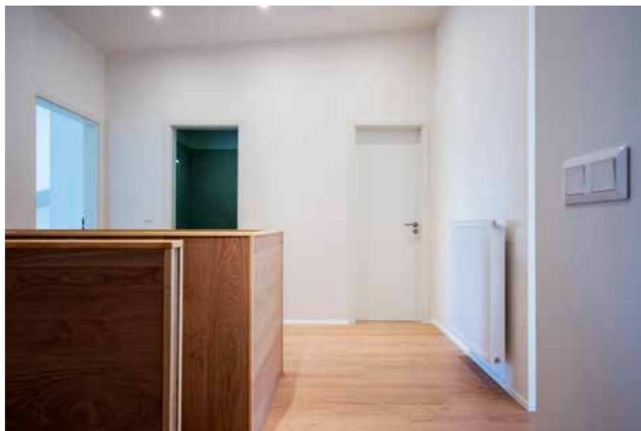
> Kromě některých nosných zděných stěn jsou všechny ostatní příčky sádrokartonové včetně jedné mezibytové stěny
