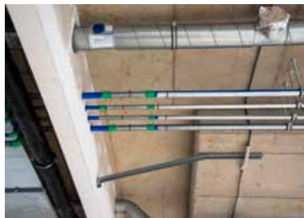
> Náročná provedení zavěšených čel s mnoha instalacemi a kluzným napojením musí odolat značnému namáhání
