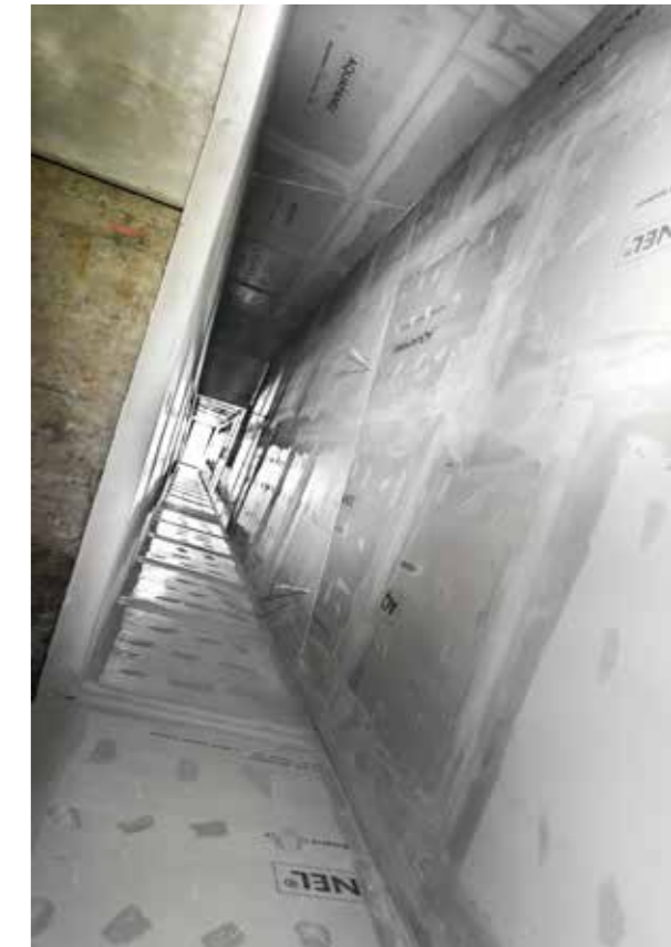
> Pohled do šachty procházející celou budovou postavenou s pomocí Knauf AQUAPANELU
