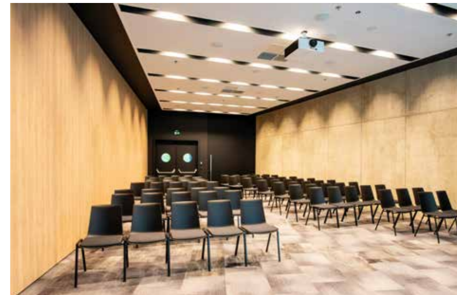
> Akustický podhled v přednáškovém sále a jeho perfektní provedení s Knauf Cleaneo a UFF hranou
