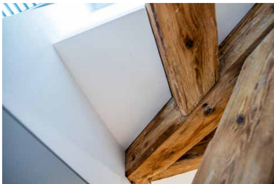
> Teleskopické dveře se svěšenou příčkou a perfektní provedení detailů s optickou spárou kolem krokví
