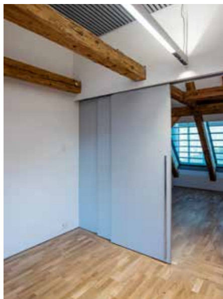
> Teleskopické dveře se svěšenou příčkou a perfektní provedení detailů s optickou spárou kolem krokví
