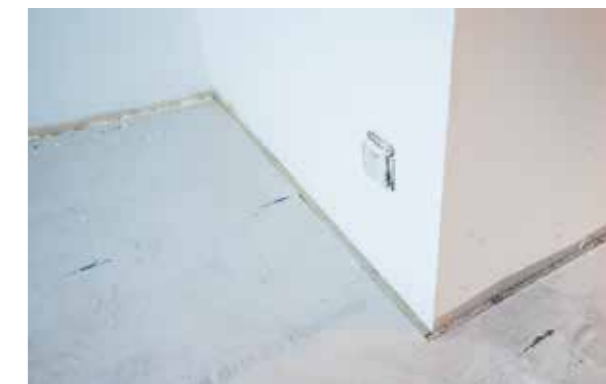
> Skvělou a ceněnou vlastností podlahy Knauf Brio je její zatížitelnost již v nepatrné vzdálenosti od okraje: bodové zatížení může být umístěno už 25 mm od okraje!
