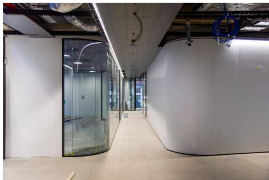
> Některé zaoblené stěny byly nakonec obloženy MDF deskami s lakovaným nebo dýhovaným povrchem
