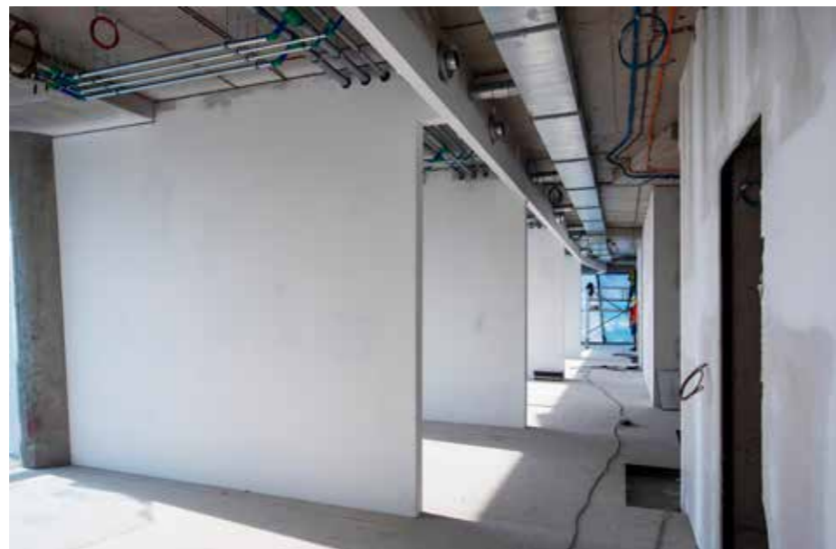
> Náročná provedení zavěšených čel s mnoha instalacemi a kluzným napojením musí odolat značnému namáhání
