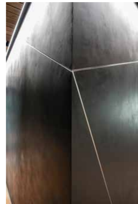
> Detail titanové lišty "vložené" do sádrokartonu
