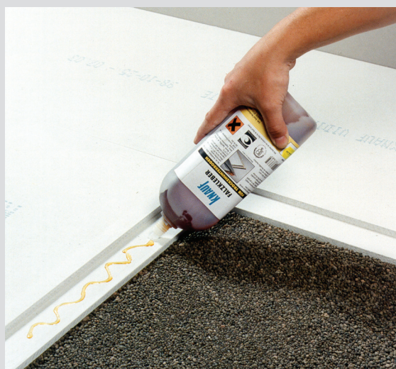
Nanesení lepidla na polodrážku (F 131)
