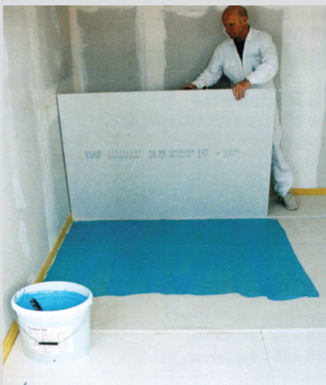
Pokládka 2. vrstvy podlahy na lepidlo Aqualine 759 (možno použít Uniflott)
