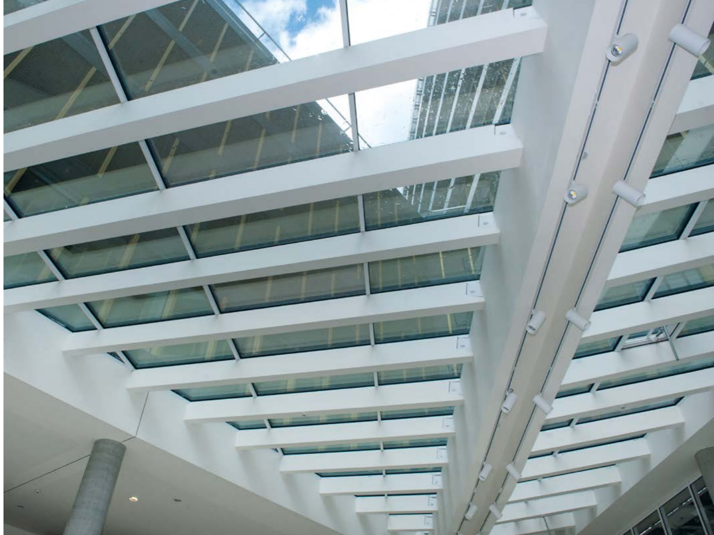
▲ Požární opláštění nosné ocelové konstrukce se opravdu povedlo a pohled proti obloze je impozantní.
