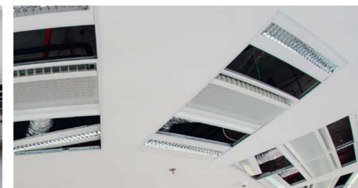
▲ Oba trakty budov spojuje prostorná prosklená recepcce s děrovanými podhledy pro zlepšení akustického dozvuku.
