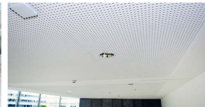
▲ Oba trakty budov spojuje prostorná prosklená recepcce s děrovanými podhledy pro zlepšení akustického dozvuku.
