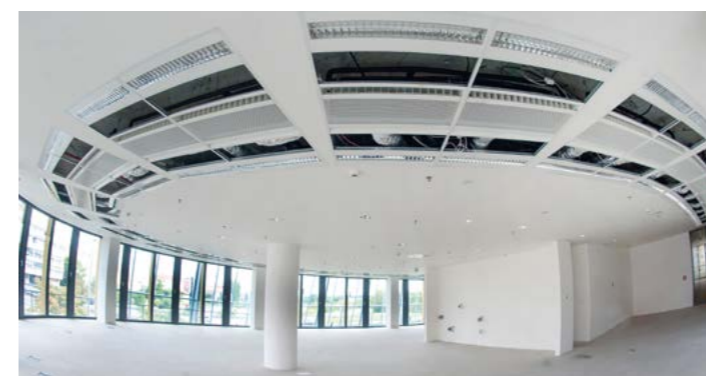
▲ Oba trakty budov spojuje prostorná prosklená recepcce s děrovanými podhledy pro zlepšení akustického dozvuku.
