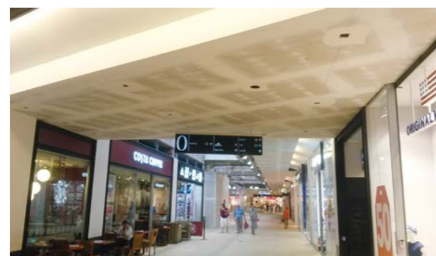
▲ Rekonstrukce stávající části Centra Chodov probíhá celý čas bez omezení běžného provozu pro zákazníky. Ve vnitřních prostorech centra se pracuje hlavně v noci. Ukázka rekonstrukce podhledu v pasáži nákupního centra.
