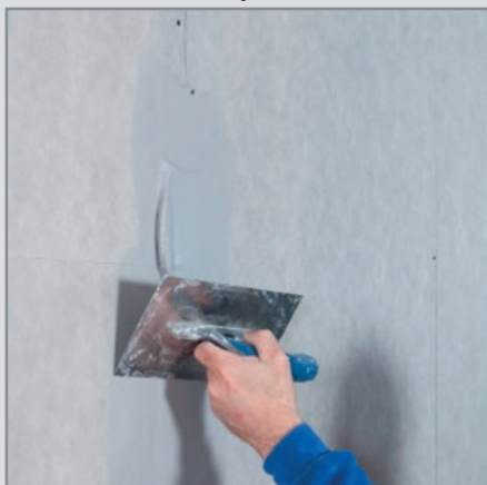
Krok 1: Vypĺíte spáru systémovým tmelem Drystar-Filler
