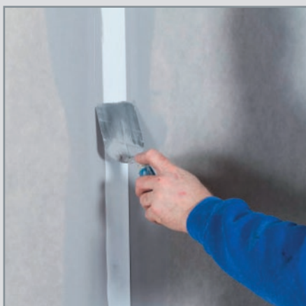
Krok 3: Přitlačte výztužnou pásku Knauf Kurt na spáru.
