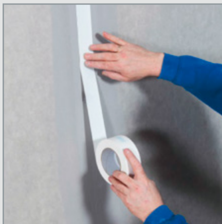
Krok 2: Spoje desek překryjte výztužnou páskou Knauf Kurt.
