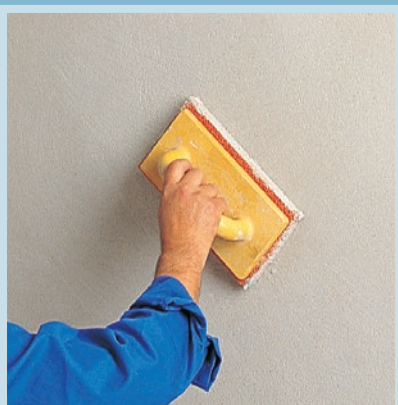
Po cca 50 minutách se při mírném navlhčení rozfilcuje
