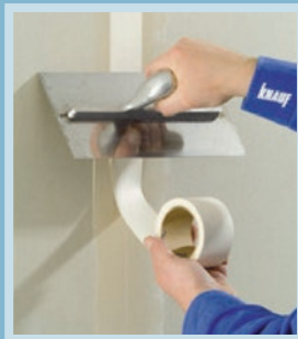
Vložení papírové pásky do sádrového tmelu
