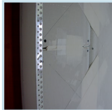
Tmelení hrany HRAK se samolepící páskou (svislá), příčné hrany se skelnou páskou a použití ochrany rohů
