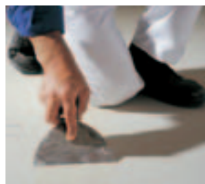
Stykové spáry desek vyplňte tmelem Uniflott
