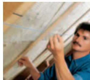
Montáž parozábrany a dřevěných latí
