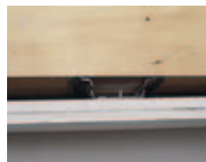
opláštění podkroví na prvku Federschiene
