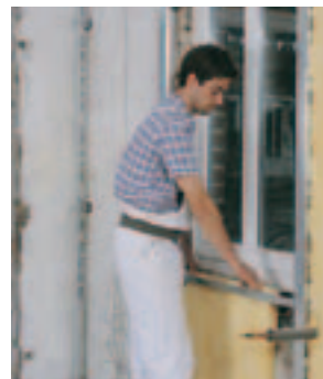
aplikace tepelné izolace
