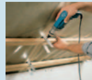
Upevnění montážních latí na konstrukci krovu
