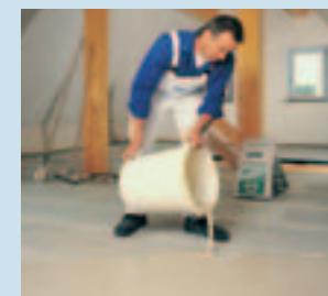
Ve stěrkové hmotě Knauf Nivellierspachtel 15 nevzniká prnutí, a tedy je ideální pro vystěrkování suchých podlah.
