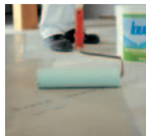
Povrch penetrujte přípravkem Knauf Estrichgrund (zředěným vodou v poměru 1:1).
