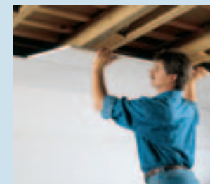
Opláštění vodorovné části podkroví
