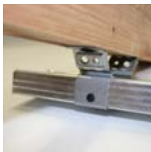
CD profil na CD klipu na krokvi
