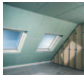
Dokončené opláštění – příprava ke tmelení
