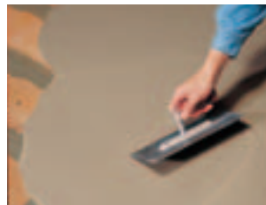
Nerovné dřevěné podklady lze vyrovnat stěrkovou hmotou Fließspachtel Faserflex 15.
